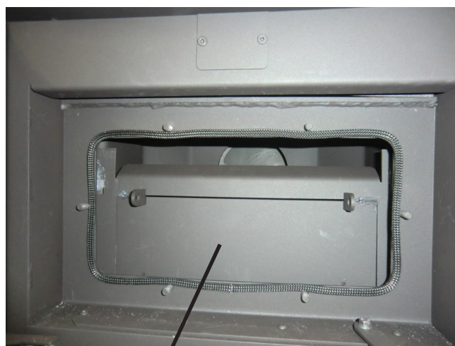
Fig. 5 Cloison échangeur de chaleur à eau
